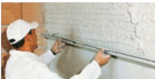
شکل ۱۴-۲ به علت سرعت بالای اجرای اندود، هم زمان با پاشش آن باید شمشه کشی انجام گیرد.
