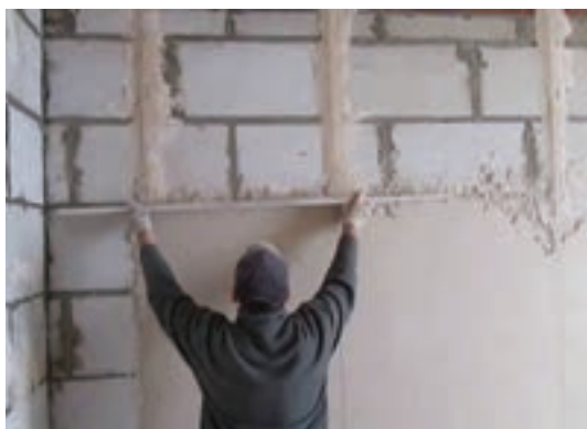
شکل ۱۳-۲ الف و ب) شمشه کشی بین کرم ها
